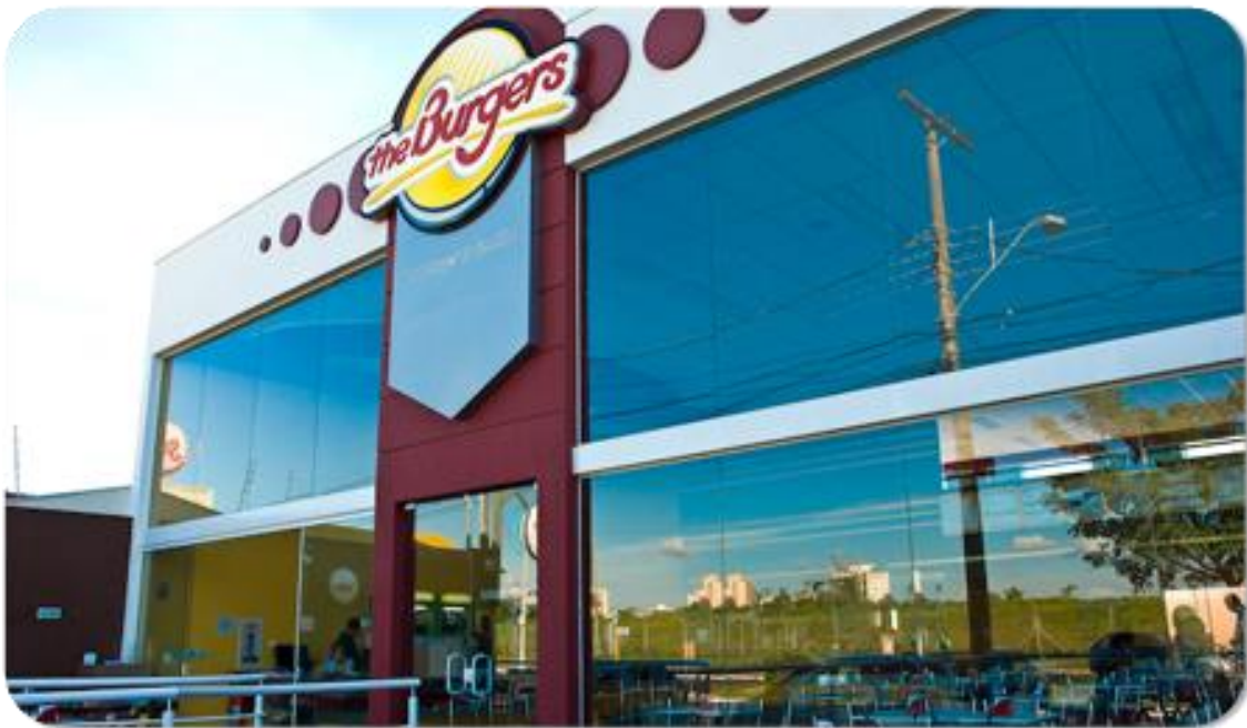
Figura 4 – Loja Piloto localizada na Avenida Getúlio Vargas em Bauru.
